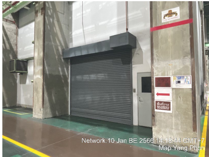
ภาพที่ 2-14 การติดตั้งผนังกันเสียงบริเวณ Chip Crusher และ Blower
