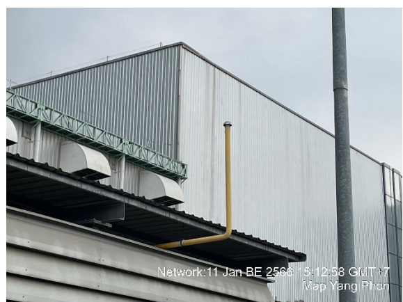
ภาพที่ 2-39 ปล่องระบายก๊าซ (Blow down stack)
