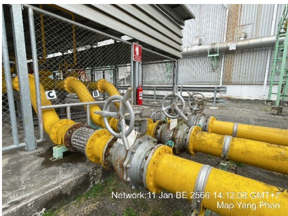
ภาพที่ 2-38 ระบบท่อ By pass และระบบวาล์วสำรอง กรณีเกิดความบกพร่องของเส้นท่อหลัก
