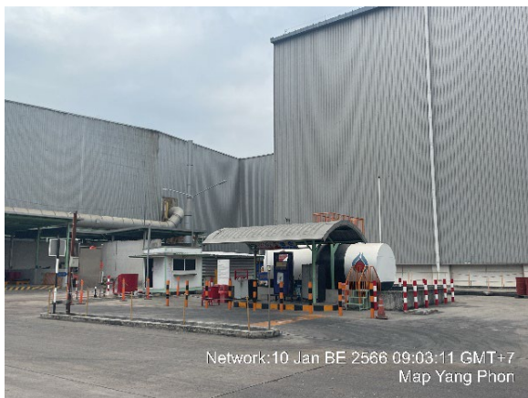
ภาพที่ 2-34 สถานีเติมน้ำมันดีเซลขนาด 20 ลูกบาศก์เมตร
