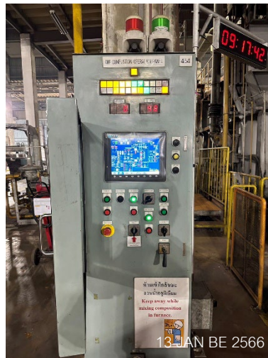
ภาพที่ 2-33 COMBINATION BOX W/MANUAL STATION LOCATION LAMP&ALARM BELL บริเวณเตาหลอม
