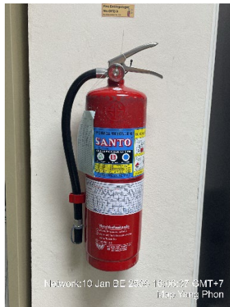
ภาพที่ 2-40 เครื่องดับเพลิงชนิดผง (Powder Extinguisher)
