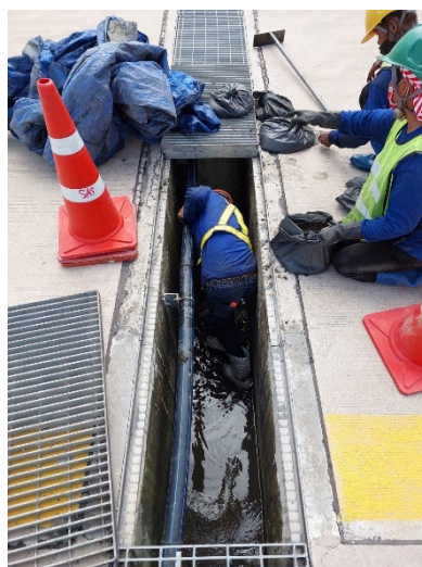
การทำความสะอาดและลอกตะกอนในรางหรือท่อระบายน้ำฝนในช่วง เดือน ม.ค - มิ.ย 2566
